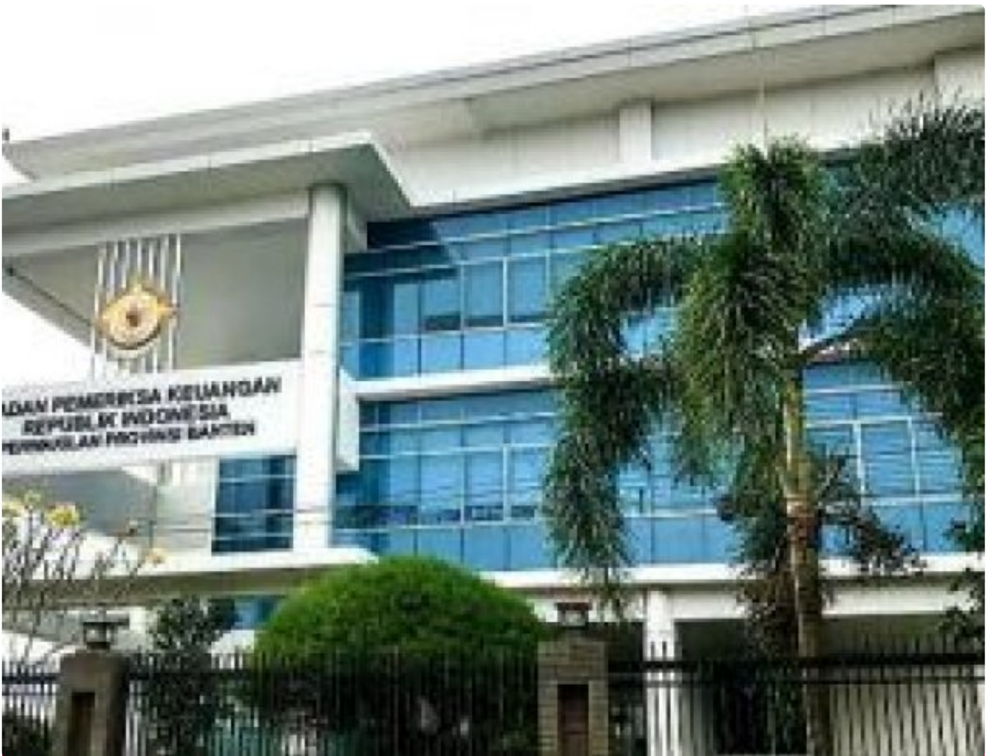
Gedung BPK RI Perwakilan Banten di Palima Kota Serang
